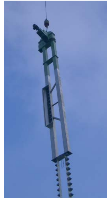
Montage des oberen Teiles eines 30 Meter langen Becherwerks.
